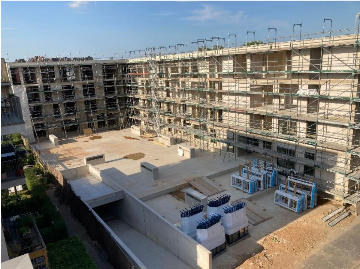
Abbildung 2. Tiefgarage noch ohne Substratüberdeckung (Ecke Josefine-Clouth-Straße / Auf dem Walzwerk). Erkennbar wird der vollständige Versiegelungseffekt einer Tiefgarage.
