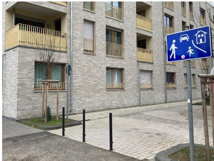
Abbildung 12: Existierende Poller im Clouth Quartier. Kautschukstraße
